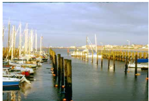
Die beiden hölzernen „Seglerbrücken“
